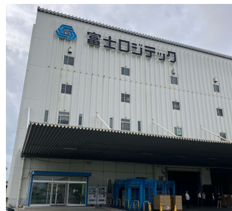
浜松ロジスティクスセンター
